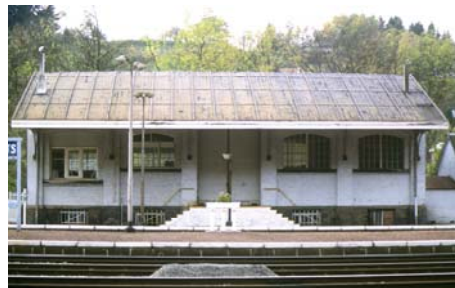
Goederenloods / Dépôt de marchandises
